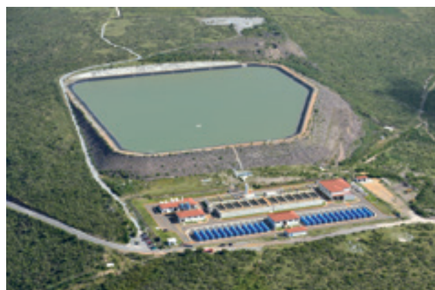
Acueducto Querétaro. México.
