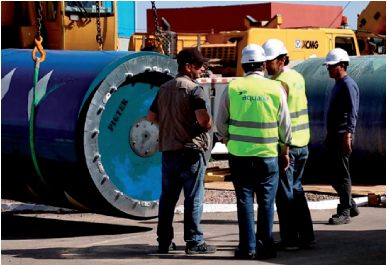
Tecnología PIG aplicada en la limpieza de los conductos de captación de agua de la desaladora de Mostaganem, Argelia.
