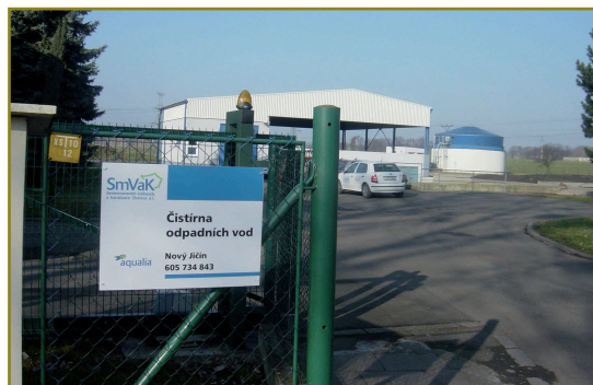
Depuradora de Nový Jičín, en República Checa, gestionada por SmVak.
