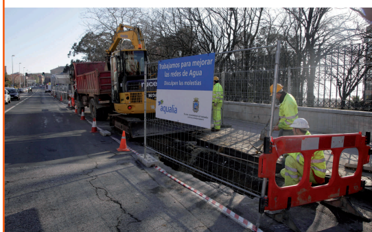
Ejemplo del mantenimiento de las redes de abastecimiento.
