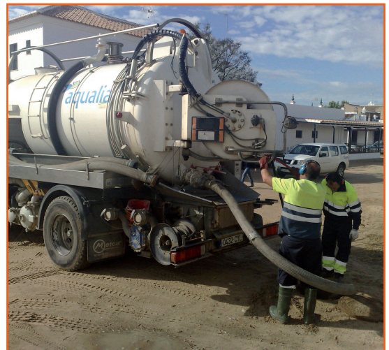
Proceso de limpieza de la red.
