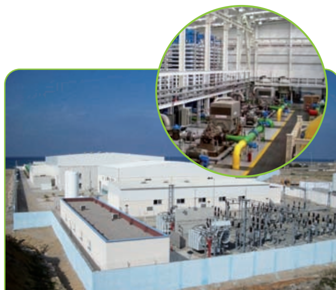
Cap Djinet (Argelia) – 100.000 m 3 /d, exterior e interior.
