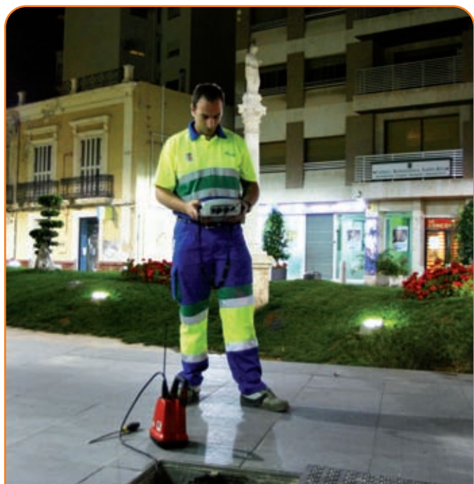
Operario aqualia localizando fugas.
